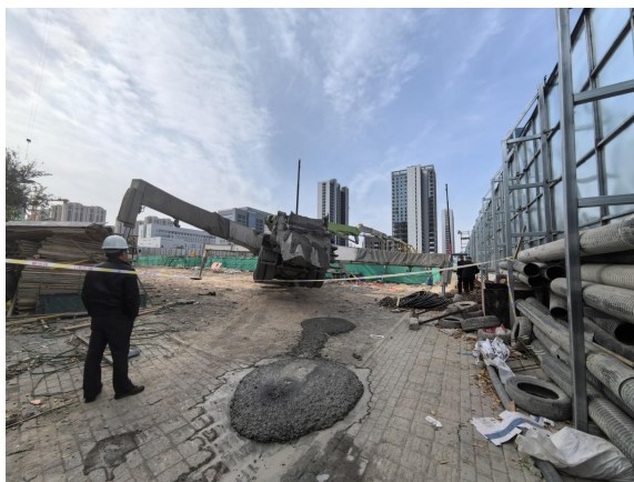
6 号楼东侧空地
