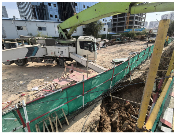
泵车停放位置
